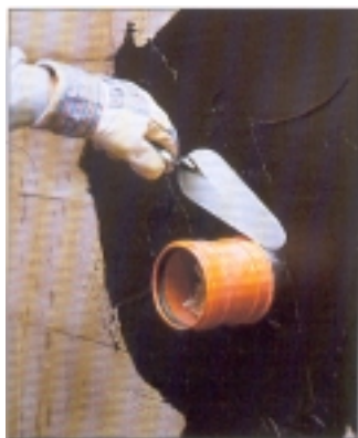
Obr. 30. Stěrkové hmoty umožňují kvalitní utěsnění prostupů a tvarově komplikovaných detailů
