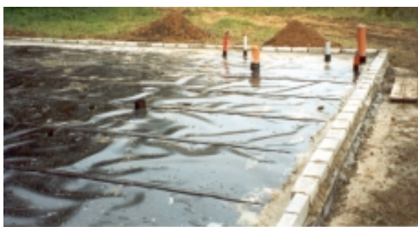
Obr. 19. Svařování HDPE fólie dvoustopým svarem se zkušebním kanálkem. Vlivem lokálního zvýšení teploty v místě sváru dochází k nevratnému zvlnění fólie.
