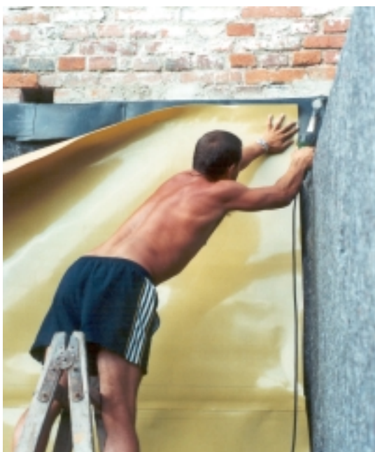
Obr. 23. Předem v horizontální poloze svařené pásy LDPE fólie (Penefol 750) na celou výšku suterénní stěny, se do vertikální polohy fixují horkovzdušným svarem při horním okraji k polyetylenové izolaci dodatečně vložené do řezové spáry pod stávajícím zdívem.
