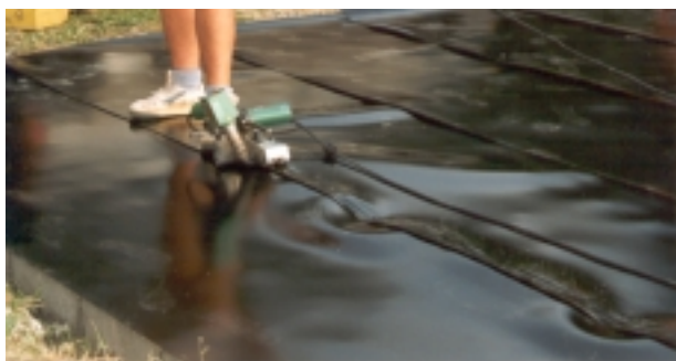
Obr. 19. Svařování HDPE fólie dvoustopým svarem se zkušebním kanálkem. Vlivem lokálního zvýšení teploty v místě sváru dochází k nevratnému zvlnění fólie.
