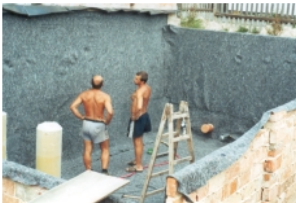
Obr. 21. Položení ochranné textilie na povrch podkladní vany.
