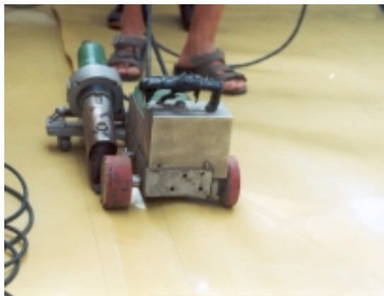
Obr. 22. Svařování LDPE fólie jednoduchým svarem. Ke zvlnění prakticky nedochází.
