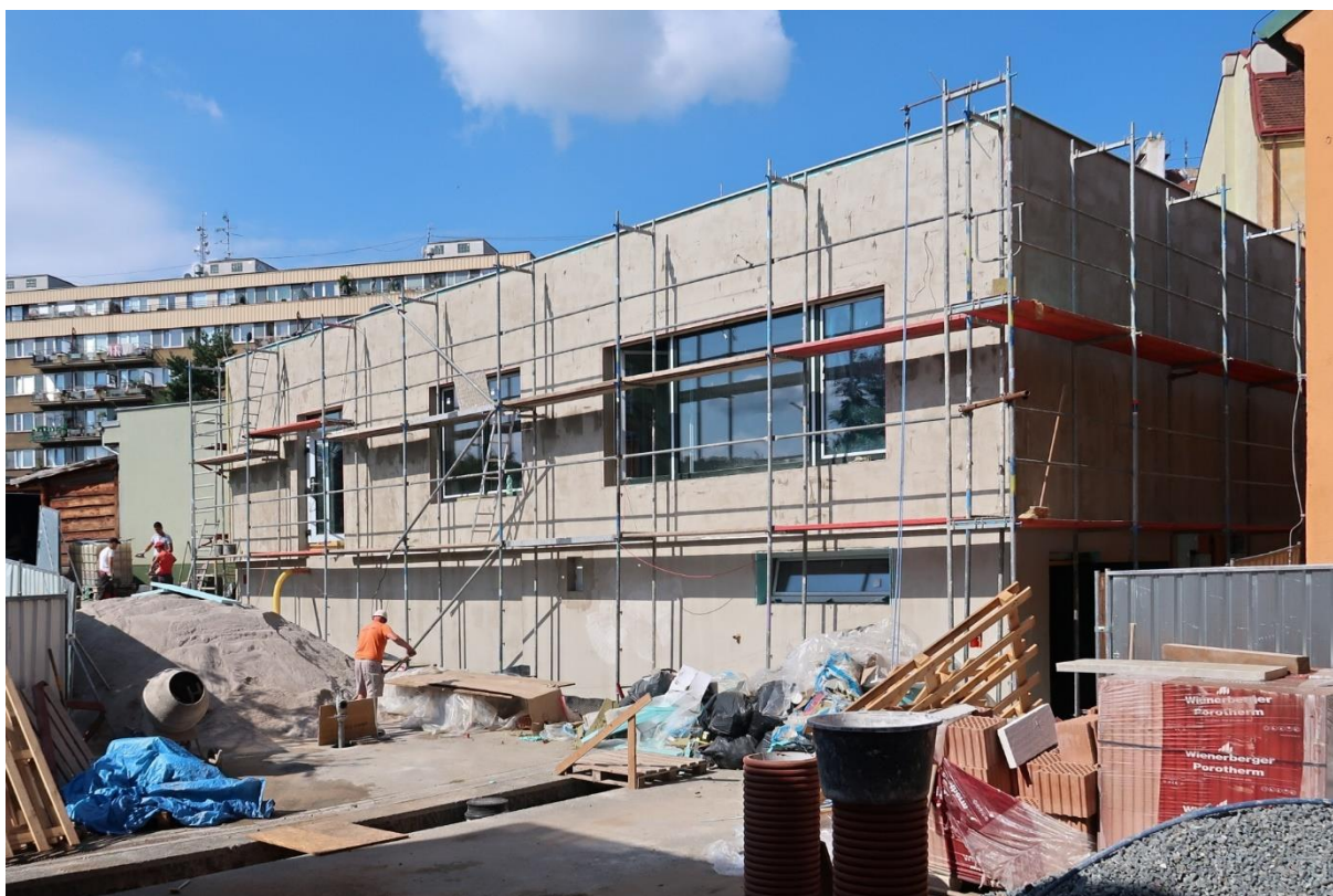
Obrázek 3: Areál Bartoškova – stavba nového objektu (2)
