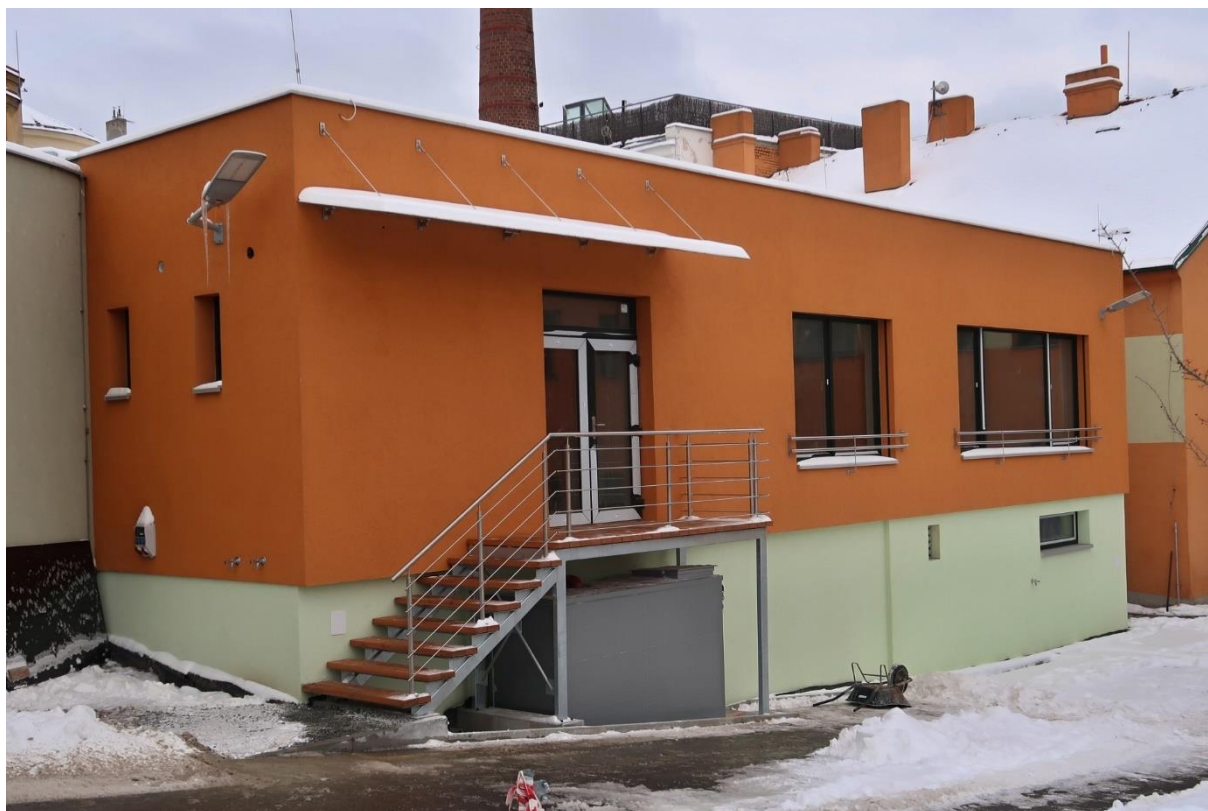
Obrázek 4: Areál Bartoškova – stavba nového objektu (3)
