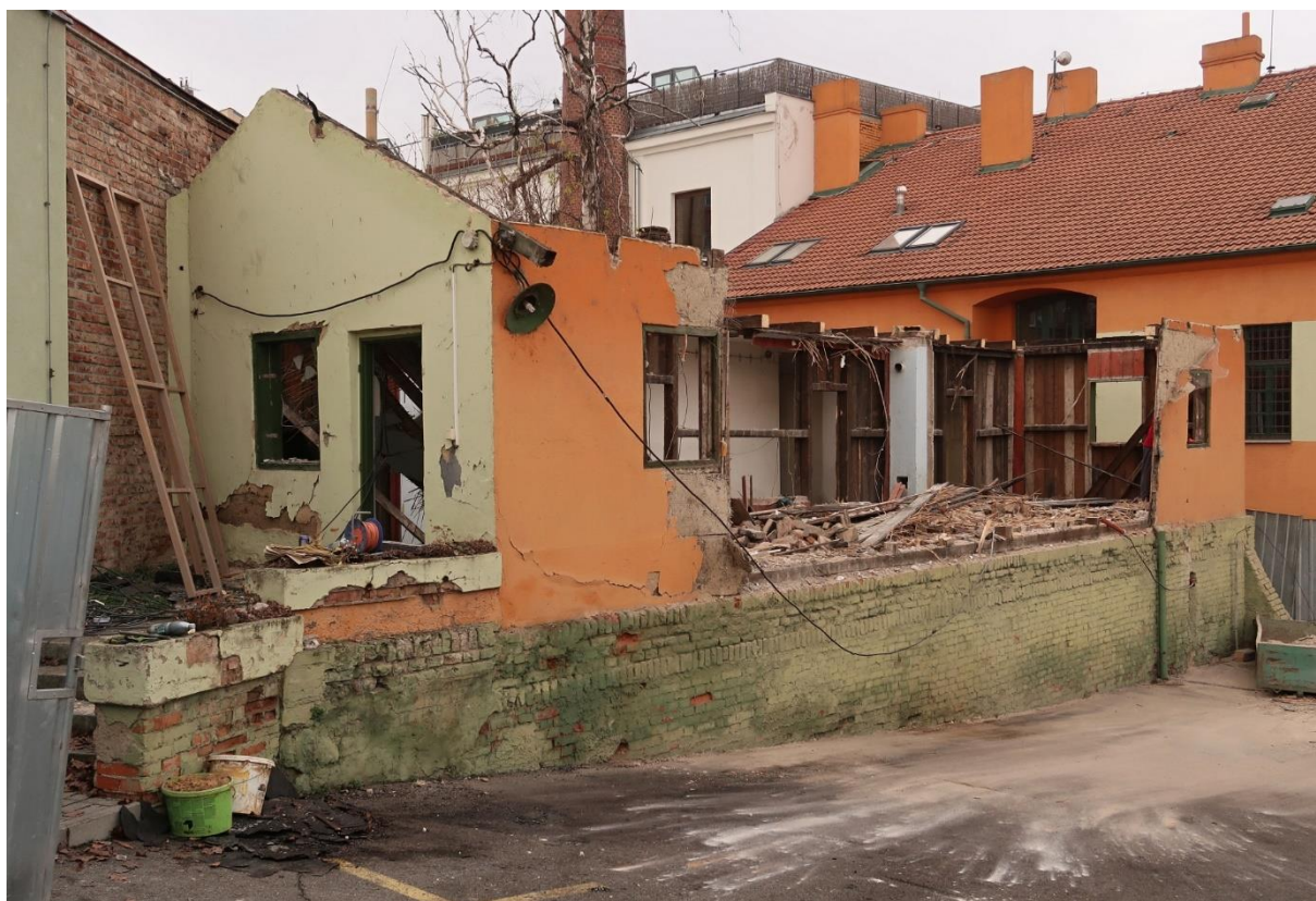
Obrázek 2: Areál Bartoškova – stavba nového objektu (1)
